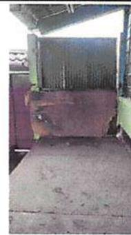
Foto 4: Sellado en muro perimetral con block de 0.15 con repello y cernido.
